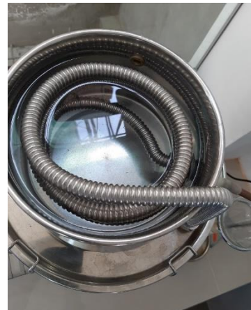
Figura 5. Pruebas de las tomas de agua a las líneas del refrigerante
