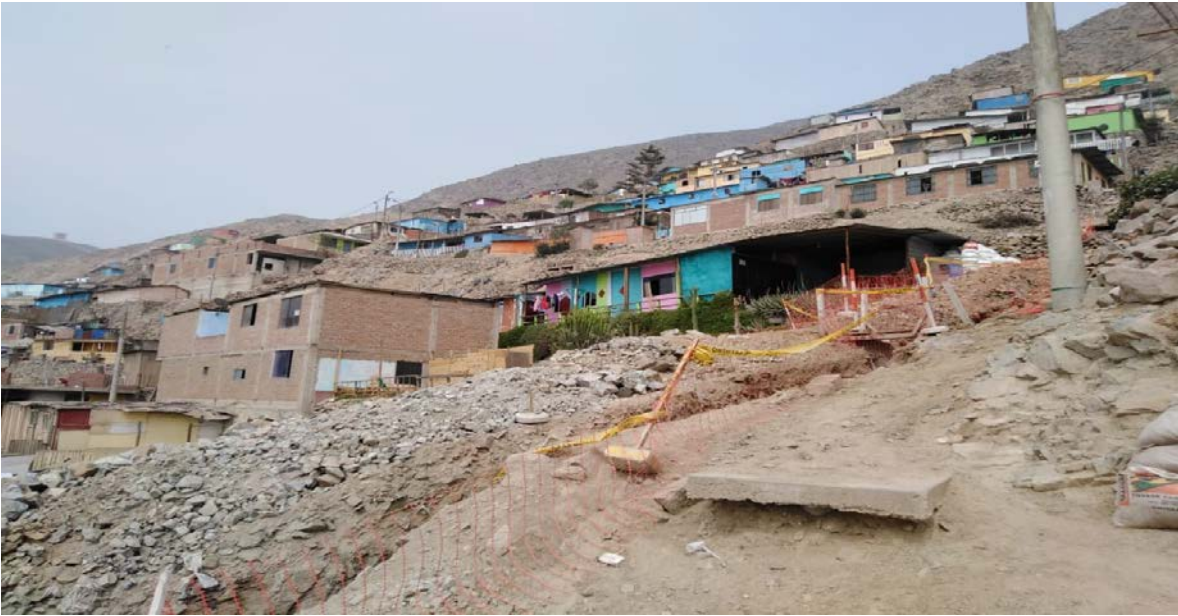
Durante el recorrido por las viviendas del Asentamiento Humano Nueva Juventud, en Huáscar - SJL.
